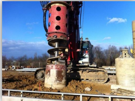
Dieser Spezialbohrer hat im Zuge der Brückenbauarbeiten über die A60 zehn Pfeiler mit je 30 Meter Länge schräg in den Boden gebohrt.
