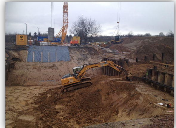
Die Tiefe dieser Baugrube am Bahnhof ist erforderlich, damit die Straßenbahn später durch die Unterführung unter den Bahngleisen fahren kann.
